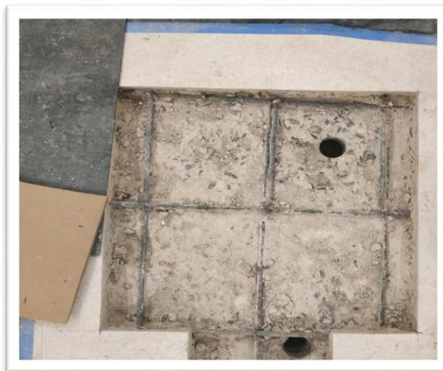
Figura 3 – Extracción de muestras de concreto estructural de la sala de Hemodinámia.
