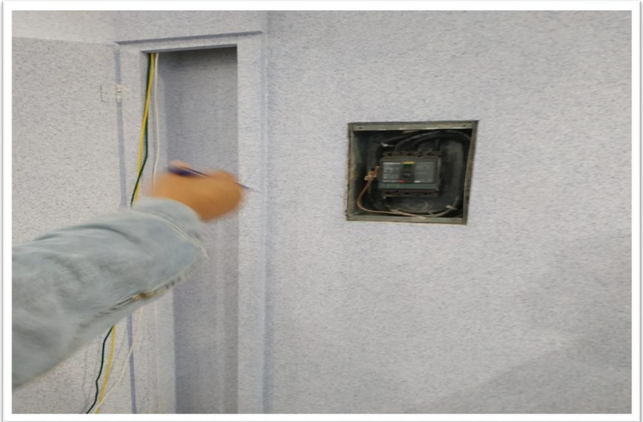
Figura 11 – Interruptor termomagnético sin bajada de cables en las salas de Rayos X.
