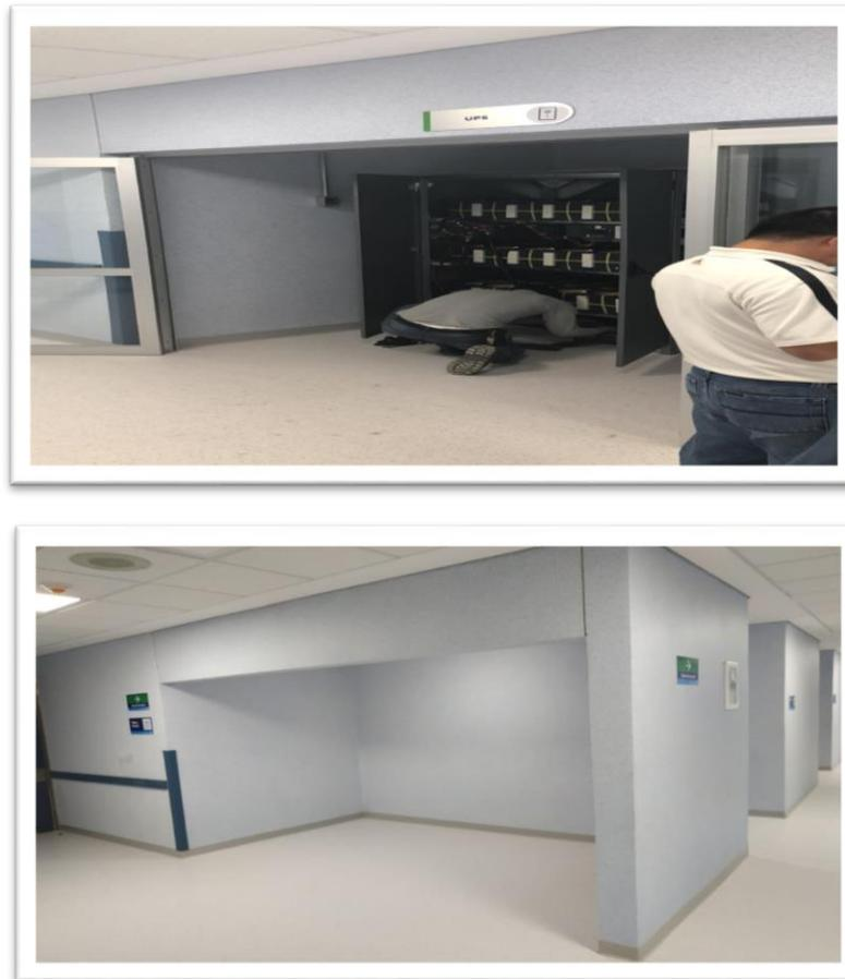
Figura 4 – Espacio designado para instalar UPS y banco de baterías del Angiógrafo[LG8].
