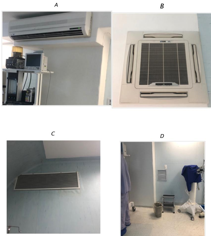
FIGURA 23. SISTEMA DE VENTILACIÓN. A) AIRE ACONDICIONADO SPLIT SALA 6-9. B) AIRE ACONDICIONADO SALAS 1-5. C) SISTEMA DE EXTRACCIÓN PARTE SUPERIOR DE LA SALA. D) SISTEMA DE EXTRACCIÓN ALTURA MEDIA.
