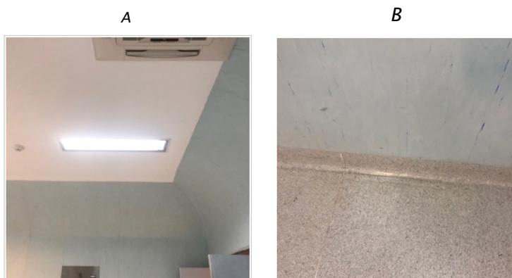
*FIGURA 22 PISOS, PARED Y TECHO LAVABLE DE SALAS QUIRÚRGICAS. A) CURVATURA ENTRE TECHO-PARED. B) CURVATURA ENTRE PARED-PISO.*
